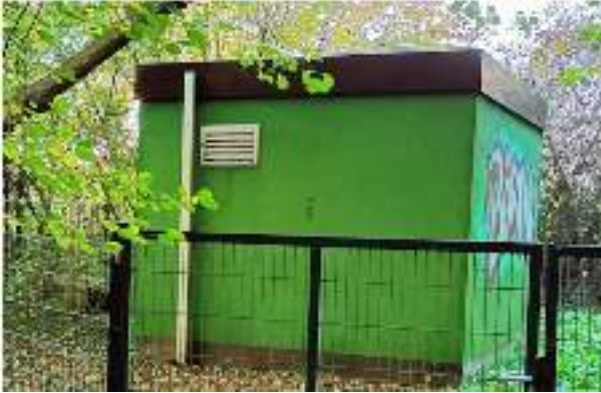
Trinkwasser-Pumpstation im Dalbek-Wald
